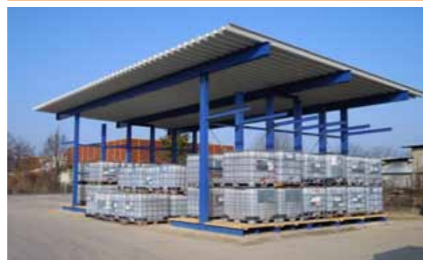
Fig. 18 Magazzino deposito CMA a Klagenfurt
