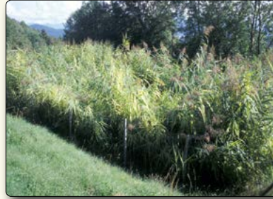
Pflanzenkläranlage mit Schilf
