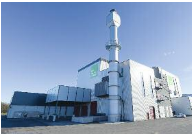
Mit der Inbetriebnahme des Biomasseheizkraftwerkes Klagenfurt Ost wurde der Anteil an Biomasse im Energienetz auf 85 Prozent erhöht. Foto: StadtPresse/Walter Fritz
