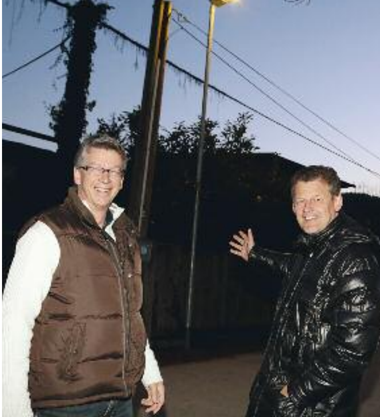
Gottfried Mirnig (Öffentliche Beleuchtung, Abt. SV) und Straßenbaureferent Stadtrat Christian Scheider besichtigen einen Teil der neu aufgestellten LED-Lichtstellen. Weitere folgen in den nächsten Wochen. Foto: StadtPresse/Wajand
