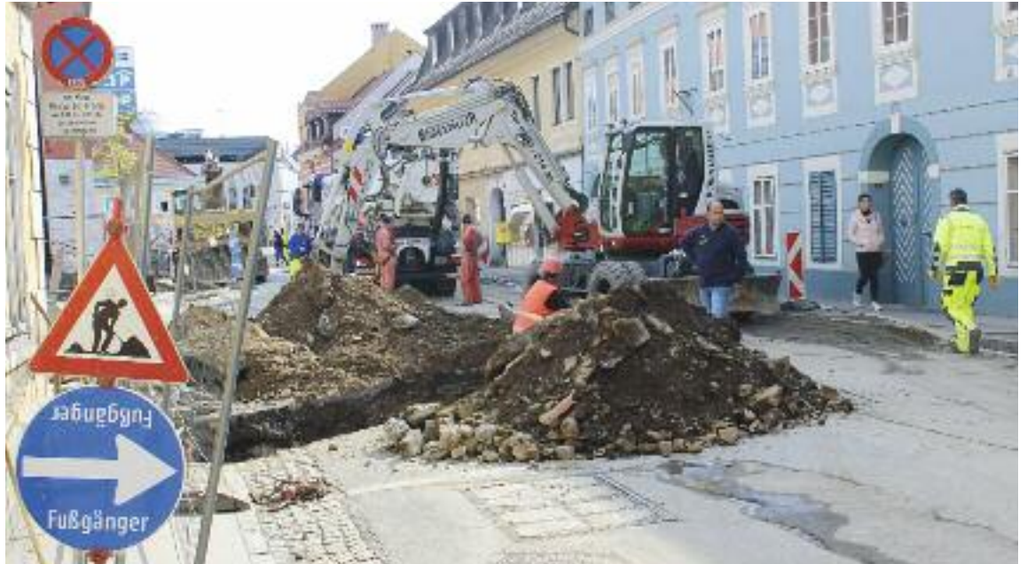
Ende Juni sollen die Kanalbauarbeiten in der St. Veiter Straße beendet sein. Bis dahin wird in einer Tiefe von bis zu sechs Metern am Hauptkanal gearbeitet und neue Hausanschlüsse verlegt. Foto: StadtPresse/Spatzek
