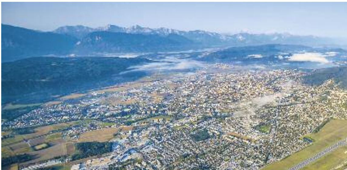
Die Trinkwasserversorgung von Klagenfurt funktioniert über ein 565 km langes Rohrnetz, welches sich durch das gesamte Stadtgebiet hin zu den 17 Hochbehältern zieht. Der Größte steht am Spitalberg und fasst 25.000 m 3 . Foto: StadtPresse/Bauer
