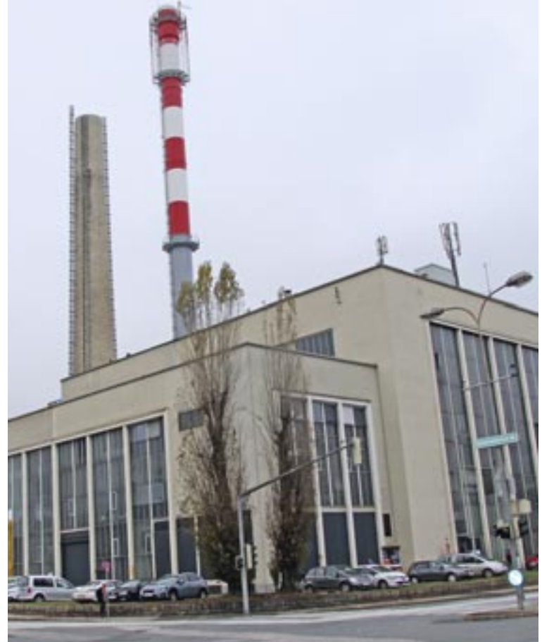
Der alte Ziegelschornstein ist bald Geschichte, er wird derzeit mühevoll Reihe für Reihe abgetragen. „Schloti“ heißt der neue Kamin des Fernheizwerkes, der nach Umstellung auf Erdgasbetrieb notwendig war.
