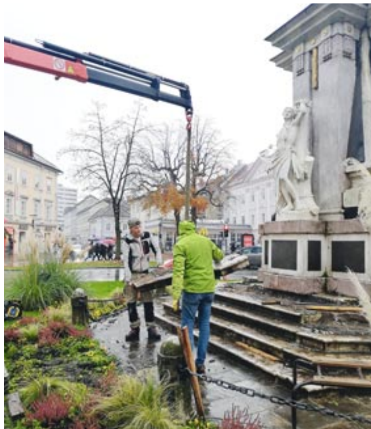
Die Stufenanlage des Florianidenkmals auf dem Heuplatz wurde bereits abgetragen. Sanierung und der Wiederaufbau folgen im Frühjahr. Foto: StadtPresse
