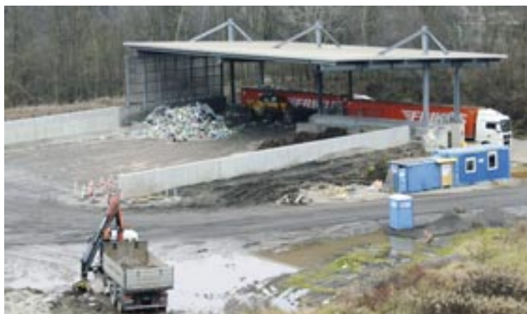
Bei der Müllverladestation wird derzeit gebaut. Begleitwände müssen neu errichtet und die bestehende Konstruktion saniert werden. Foto: StadtPresse/Spatzek
