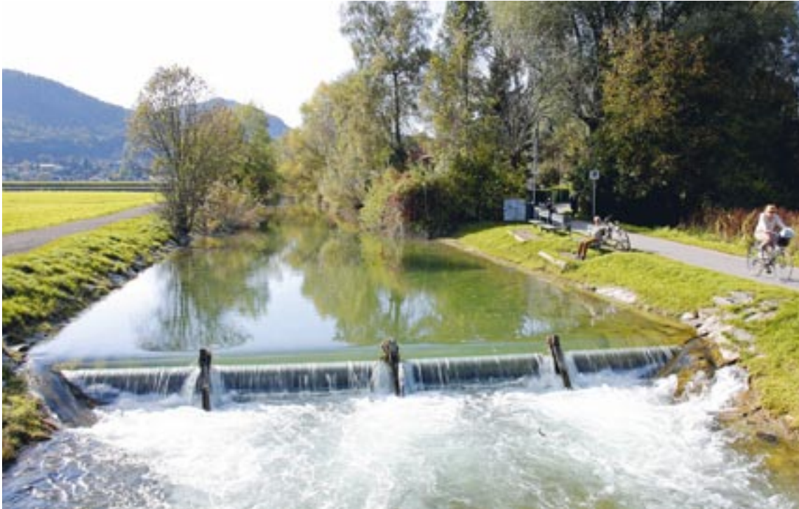
15 Millionen Euro werden im Bereich der Sattnitz für den Hochwasserschutz investiert. Foto: StadtPresse/Eggenberger
