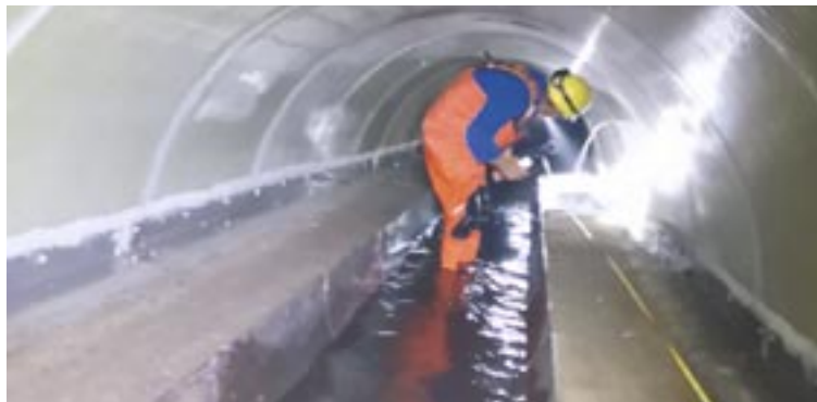
Mehrere Stunden bewegen sich die Mitarbeiter der Entsorgung im Untergrund und sorgen dafür, dass der Feuerbach noch viele weitere Jahrzehnte das Klagenfurter Abwasser reibungslos bis zur Kläranlage transportiert! Foto: KK
