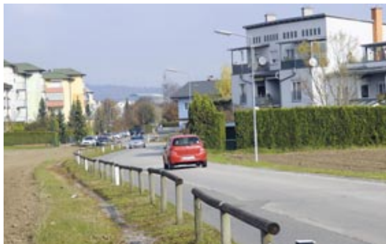
Die Keltenstraße in Viktring wird verlängert und an die Glanfurtgasse angebunden. Die Bauarbeiten könnten im Frühjahr 2021 beginnen. Foto: Stadtkommunikation
