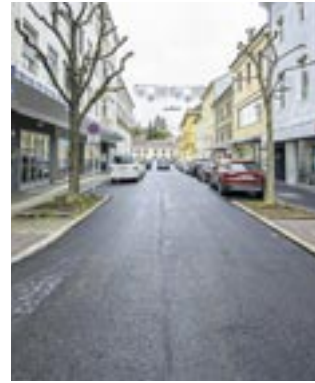
Stadt und Stadtwerke begutachten die generalsanierte Paradeisergasse: Heinz Blechl (Infrastruktur Stadt), Daniel Seebacher (CCE Ziviltechniker), Vzbgm. Wolfgang Germ, StR. Christian Scheider, StR. Markus Geiger, Erwin Smole und Franz Tomantschger (STW)
