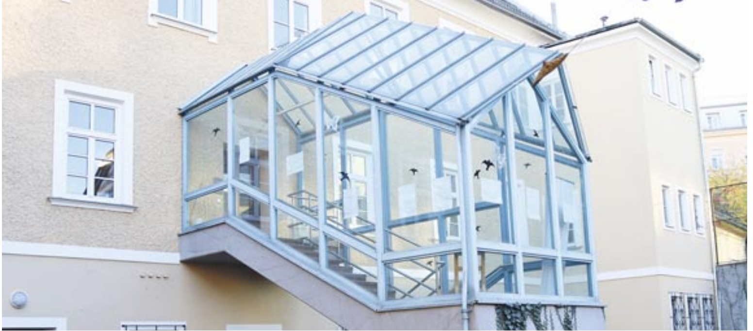
Im Eggerheim der Caritas – südlich des Benediktinermarktes – wird die neue Notschlafstelle eingerichtet werden. Foto: Rosenzopf/StadtKommunikation
