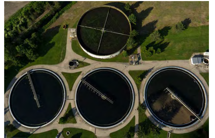
Tropfkörper und Nachklärbecken.
