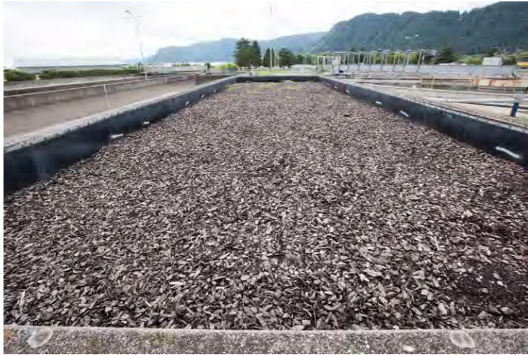
Biofilter beseitigt unangenehme Gerüche.
