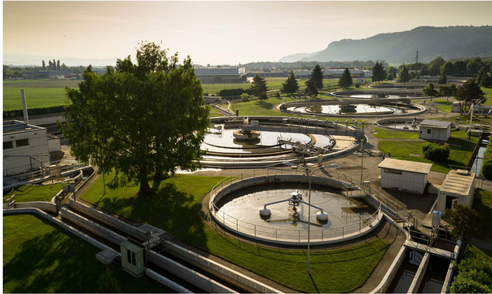
Fettfang- und Kombibecken mit Vorklärung und Belebungsbecken in der Luftaufnahme.
