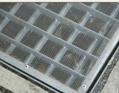
*Mit engmaschigem Drahtgitter abgedeckter Lichtschacht*
