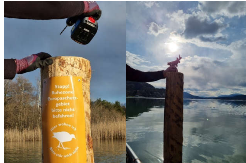
Abbildung 12: Montage von Schildern und Ansichtshindernis. Foto: Wiegele
