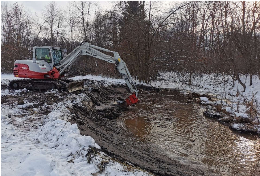
Abbildung 45: Errichtung des Amphibientümpels B
