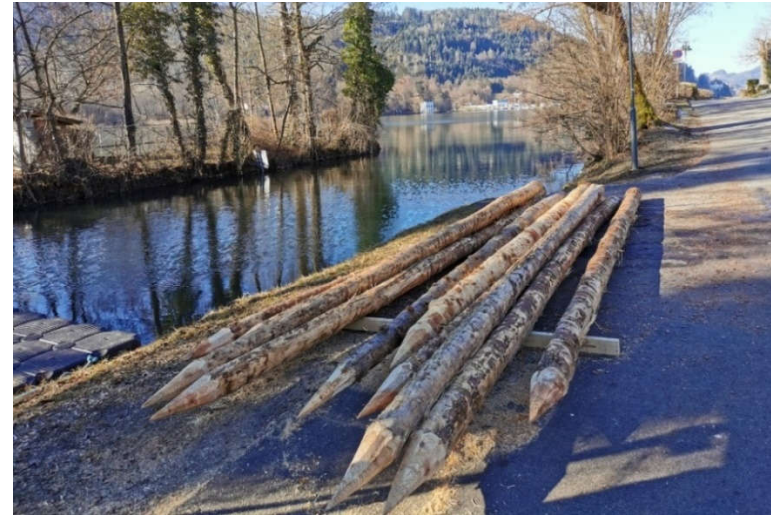
Abbildung 7: Als Piloten dienen unbehandelte Lärchenpfosten, die unten zugespitzt wurden.
