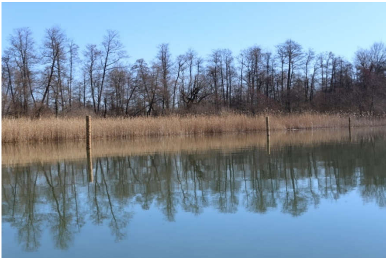
Abbildung 6: Die ersten drei Piloten wurden im Abstand von 20 m zwischen Kajakbadeplatz und Seeabfluss errichtet. Foto: Glatz-Jorde
