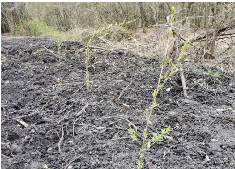
Abbildung 49: Initialbepflanzung mit Weidenstecklingen
