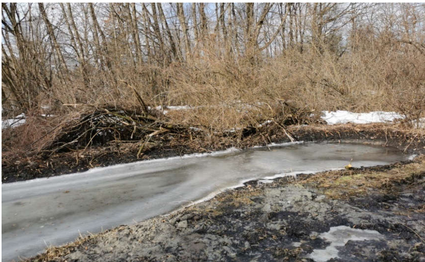
Abbildung 46: Das Amphibiengewässer B nach der Fertigstellung im Februar 2021
