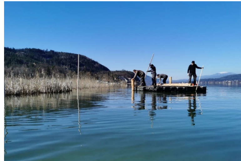
Abbildung 8: Vorarbeiten für den Schilfschutzzaun bei der Seeabflussausfahrt. Foto: Glatz-Jorde
