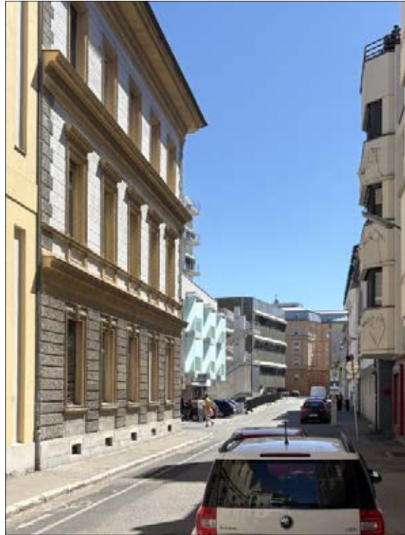
Adolf-Kolping-Gasse - heterogene Bebauung unterschiedliche Bauzeitalter und Fassadengestaltung (Eigene Aufnahme)
