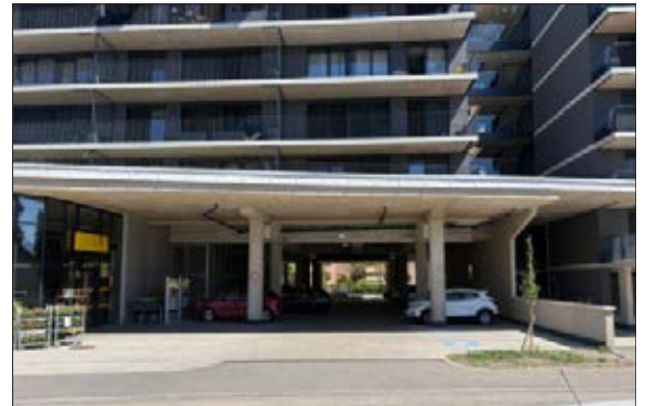
Hans-Sachs-Straße - Parkplatzüberbauung Architektur: Lendarchitektur ZT GmbH (Eigene Aufnahme)
