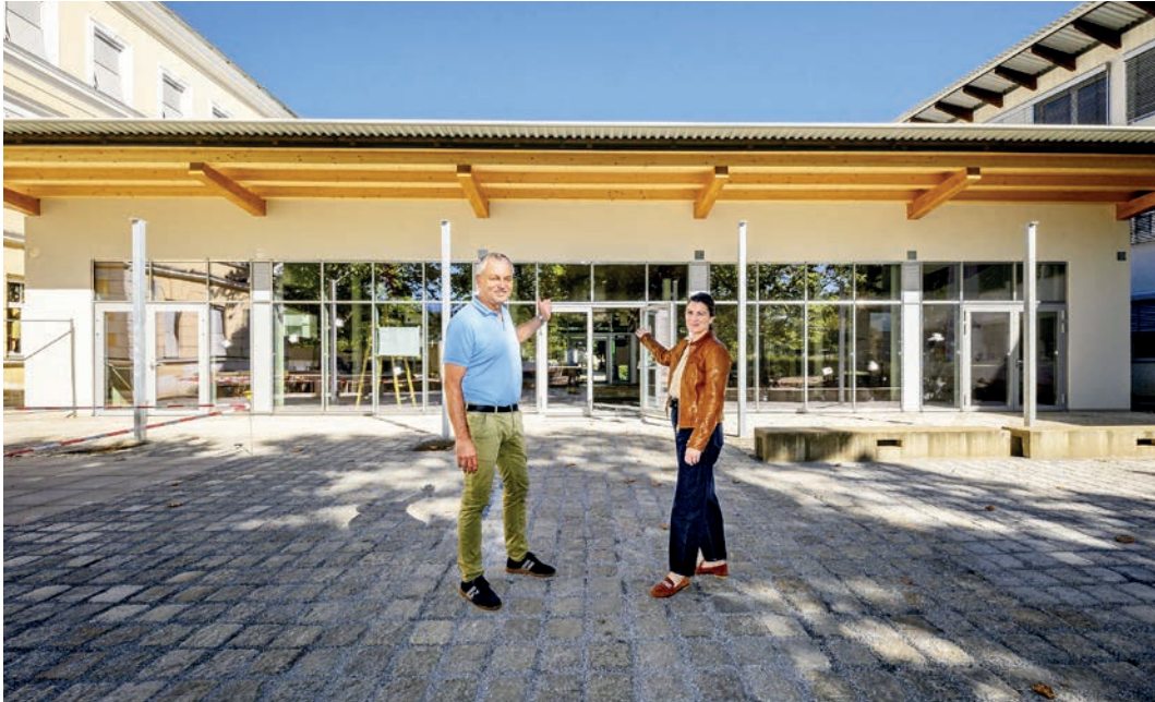
Der Aulabereich der Volksschule in Viktring wurde erweitert. Stadtrat Max Habenicht macht sich vor Ort ein Bild von den Umbauarbeiten. Fotos: SK/Hude
