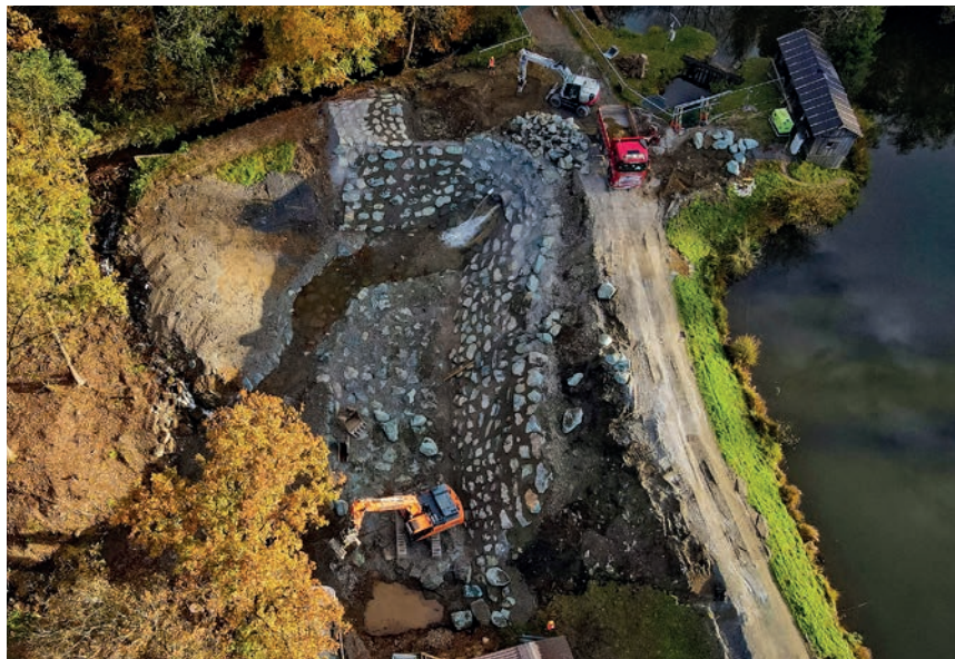
Beim Treimischer Teich werden die Dammkrone erhöht und neue Überströmbecken gebaut (links). Als Sicherung der Häuser in Poppichl konnten vor Kurzem die neuen Hochwasserschutzmauern fertiggestellt werden (rechts). Fotos: Helge Bauer, SK/Glinik
