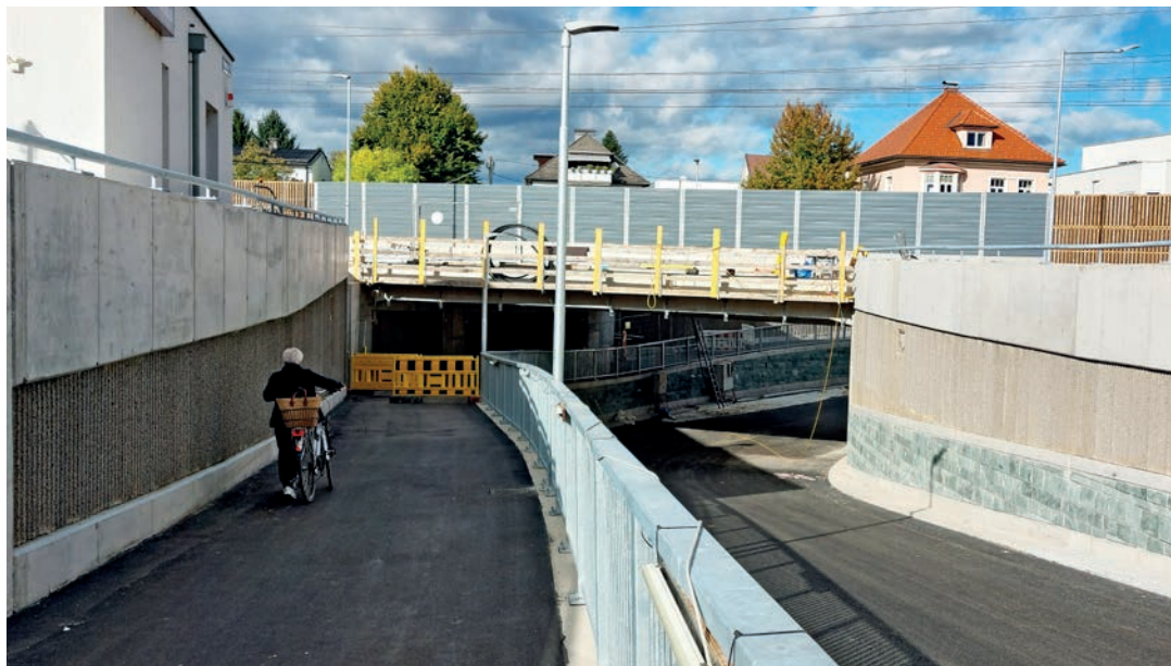
Die neue Unterführung verbessert die Sicherheit für Verkehr, Radfahrer und Fußgänger. Foto: ÖBB
