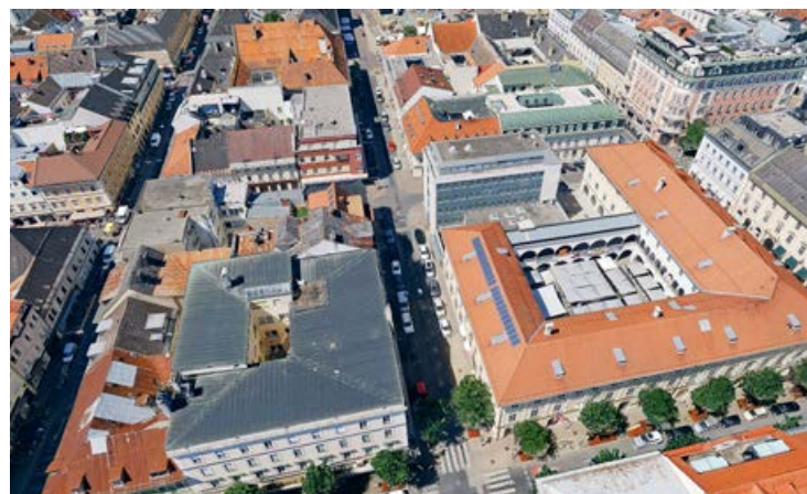
Wegen Bauarbeiten erfolgt ab 17. August die Sperre der Paradeisergasse (Bildmitte) zwischen Bahnhofstraße und Neuer Platz. Foto: Digitaler Zwilling
