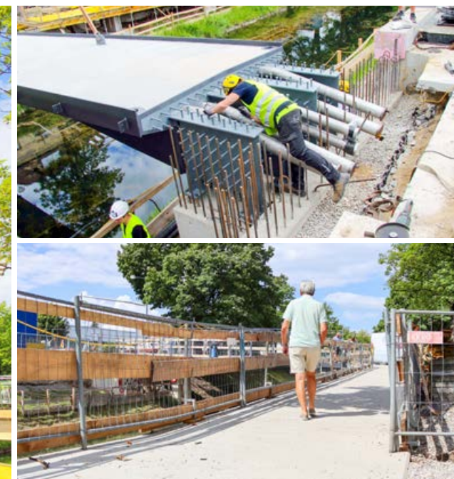
Mittels Kran wurde die gewichtige Stahlkonstruktion langsam eingehoben (links). Das Aufsetzen auf die Brückenwiderlager erforderte Millimeterarbeit (rechts oben). Seit Mitte Juli ist der neue Heinzelsteg provisorisch zum Überqueren freigegeben (rechts unten). Fotos: SK
