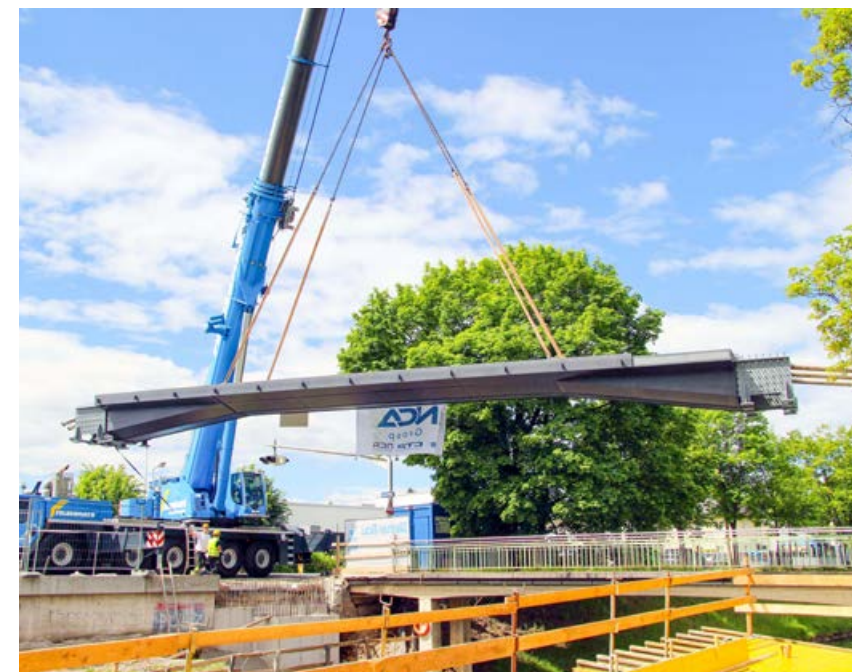
Mittels Kran wurde die gewichtige Stahlkonstruktion langsam eingehoben (links). Das Aufsetzen auf die Brückenwiderlager erforderte Millimeterarbeit (rechts oben). Seit Mitte Juli ist der neue Heinzelsteg provisorisch zum Überqueren freigegeben (rechts unten). Fotos: SK
