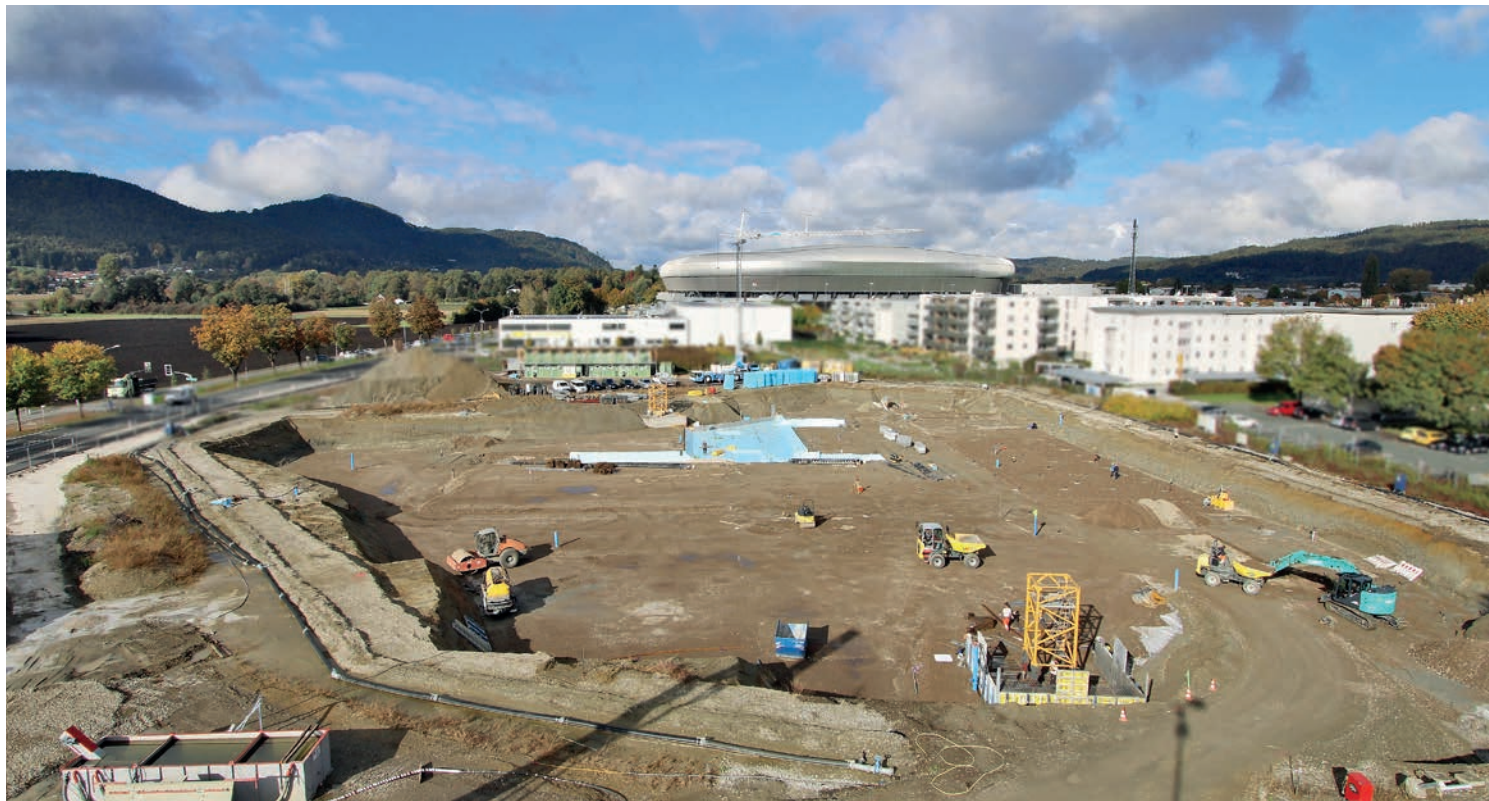
Die Baugrube vom Alpen-Adria Familien- und Sportbad am Südring ist ausgehoben, an der Bodenplatte wird bereits gearbeitet. Foto: Stadtwerke Klagenfurt
