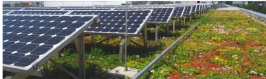
Abb. 130: PV-Außtachtanlage mit extensiver Dachbegrünung (Foto: ZinCo GmbH)
