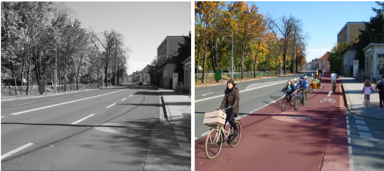
Abbildung 7.10 Vorher-Nachher Visualisierung zur Adaptierung der Straßenquerschnitt Villacher Straße (Grafik PLANUM Fallast Tischler & Partner 2017)
