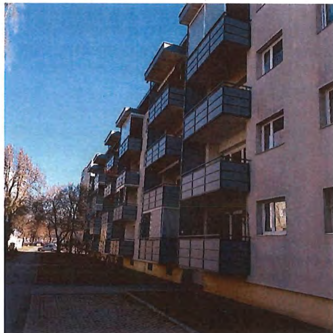
Balkonsanierungen in der Fischl-Siedlung
