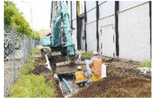
Entsorgungsreferent Vzbgm. Wolfgang Germ besichtigt den Baufortschritt beim Schmutzwasserkanal beim Lakeside Park (l.). Wegen schlechter Bodenverhältnisse müssen in dem Bereich lange Eisenrohre tief in die Erde gebohrt werden (r. o.). In der Florian-Gröger-Straße bei der Messe wird der Kanal saniert (r. u.). Fotos: StadtPresse/Spatzek
