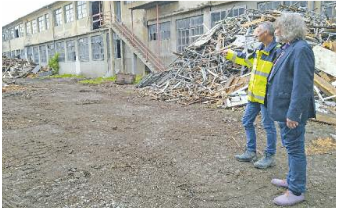
Stadtrat Frank Frey überzeugte sich vor Ort von den getroffenen Vorkehrungen bei der Sanierung des Geländes und wurde von Dipl.-Ing. Reinhard Höchtl durch das Areal geführt. Foto: StadtPresse/Burgstaller
