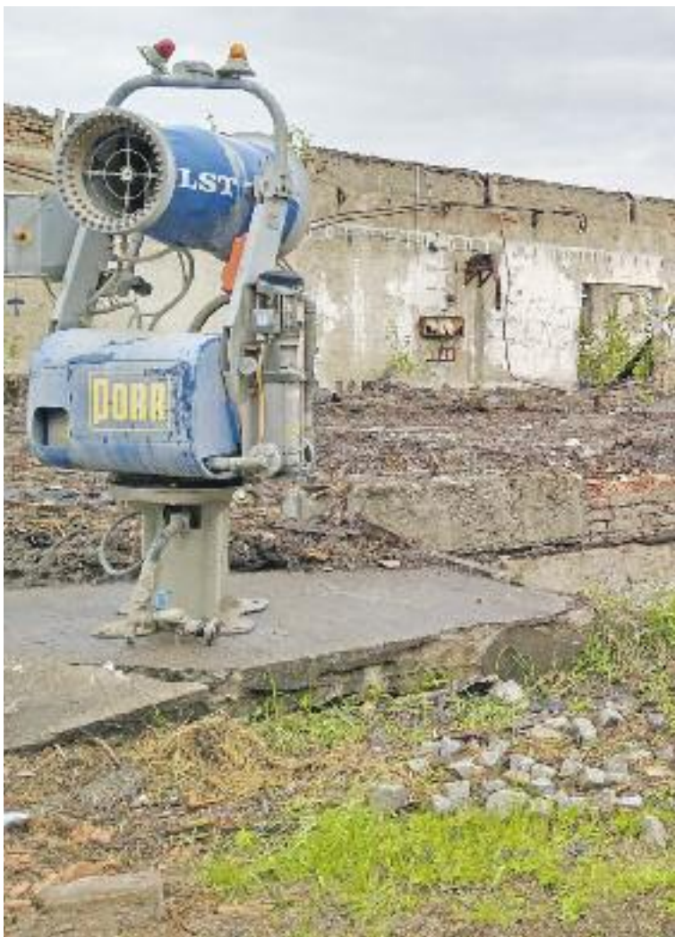
Um die Staubbelastung so gering als möglich zu halten, kommen beim Abriss der ehemaligen Fabrikgebäude Schneekanonen als Wasserwerfer zum Einsatz (oben). Größtmögliche Transparenz ist allen Verantwortlichen wichtig. Daher gibt es regelmäßig Infoveranstaltungen für die Anrainer (unten). Fotos: StadtPresse/Burgstaller
