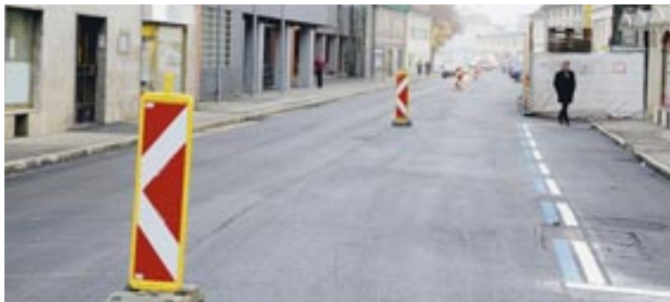
Fleckerlteppich adé! Straßenbaureferent Stadtrat Christian Scheider überzeugte sich letzte Woche von der hochwertig sanierten Fahrbahn. Foto: StadtPresse/Wajand
