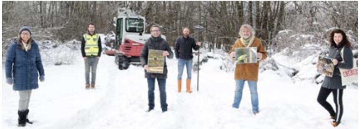
Die zuständigen Stadträte Frank Frey und Mag. Franz Petritz waren beim Baustart für die neuen Amphibientümpel im Natura 2000-Gebiet Lendspitz-Maiernigg mit dabei. Foto: Stadtkommunikation/Wajand
