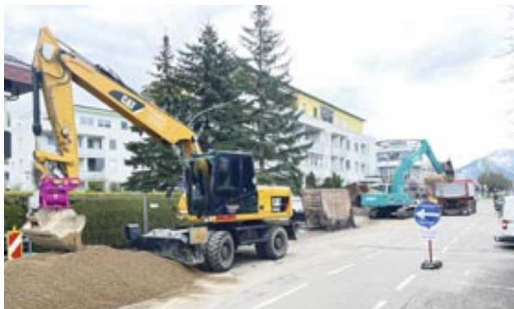
Die Bauarbeiten im Nautilusweg laufen bis Ende November. Foto: Baustellentagebuch
