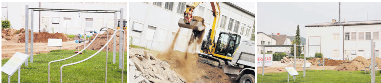
Die umfangreichen Bauarbeiten werden Anfang Oktober abgeschlossen sein. Fotos: Wajand
